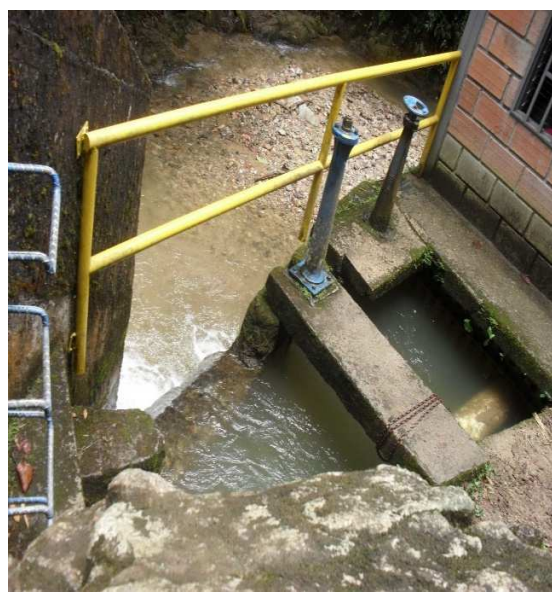
Foto 4. Canal de entrada y desarenador
