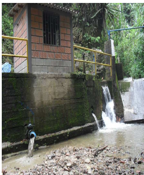
Foto 4. Canal de entrada y desarenador
